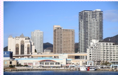
かもめりあ付近 (画像提供: Adobe)
